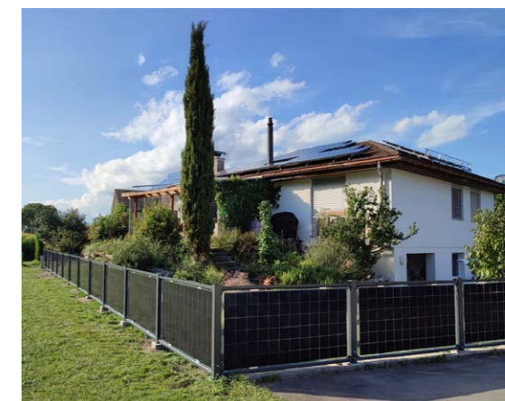
Premium Solarzaun 115 in Beton, Punktfundament
