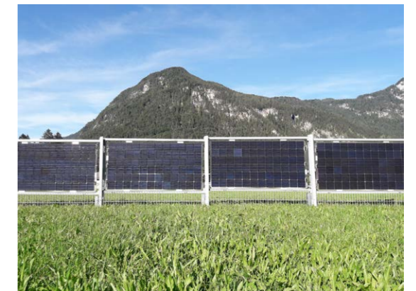
Solarzaun in Beton, Punktfundament
