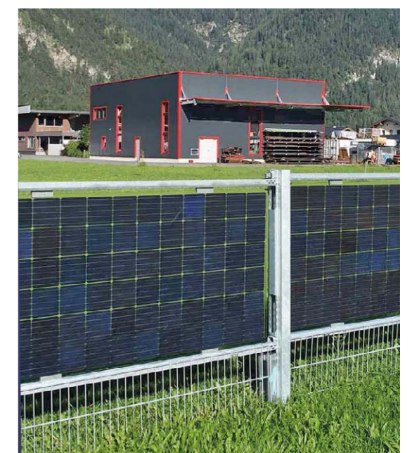
Solarzaun gerammt, mit Bodenelement
